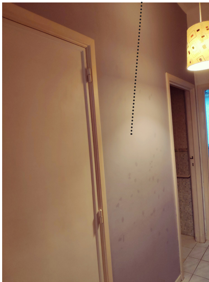
Plafonner le mur
