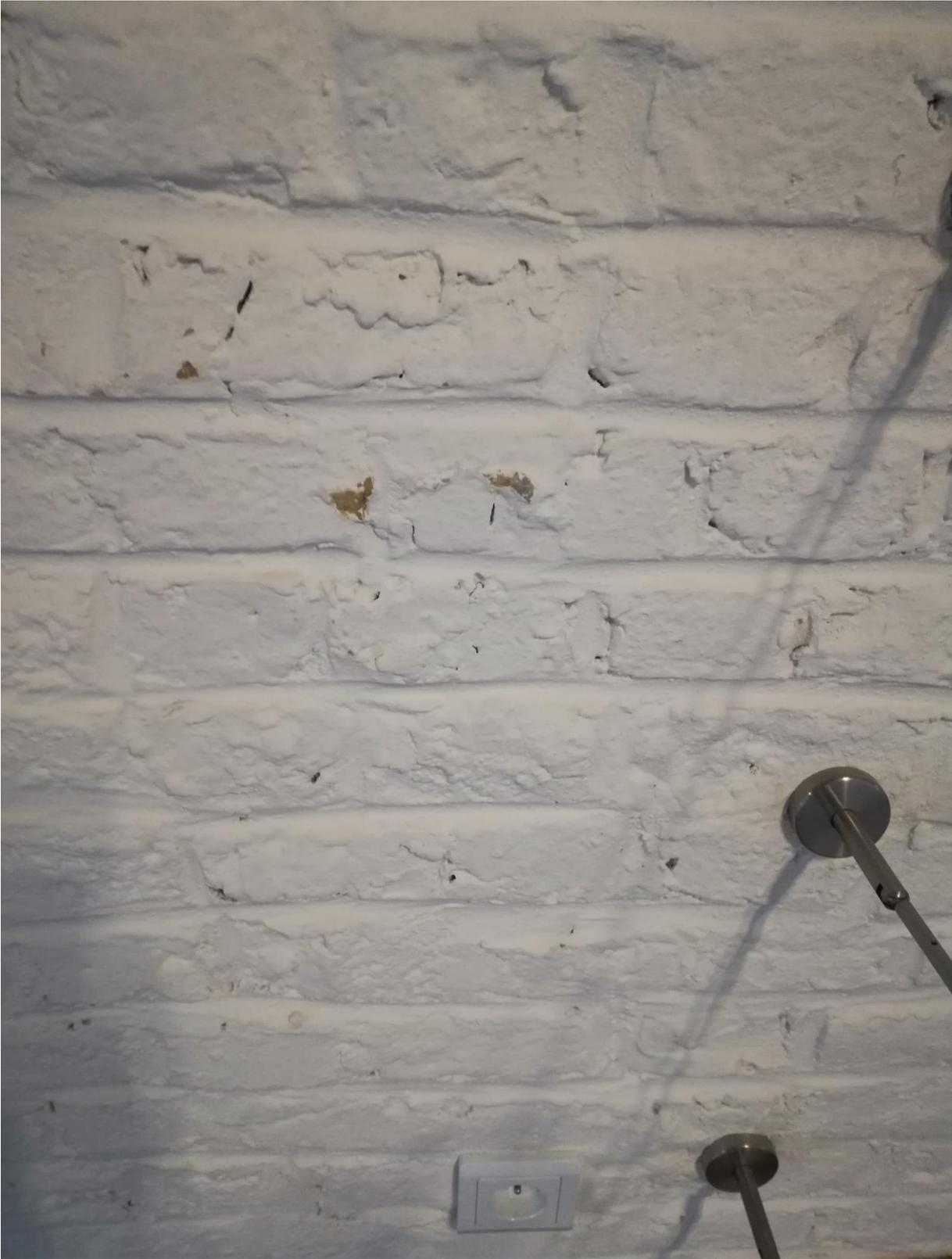
Trous et coups mal rebouchés (craquelures, défauts) à refaire dans la salle à manger à gauche du radiateur
