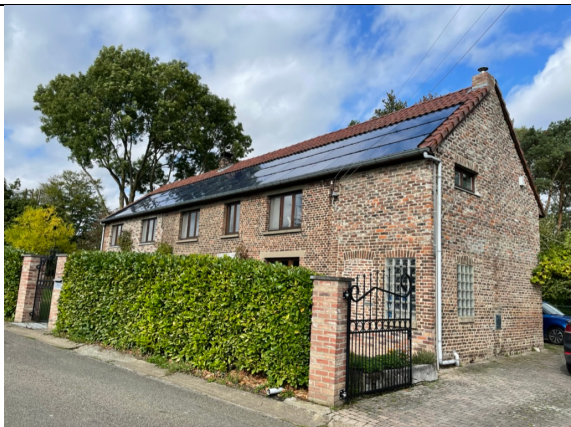
Photo 1 : rue Belle-vue 74. 4530 VILLERS LE BOUILLET
