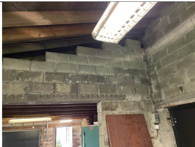
Photo 8 : mur sur poutre béton
