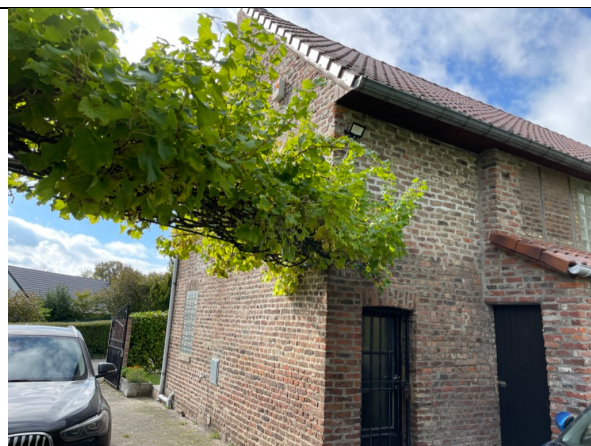
Photo 16 : façade latérale droite maison
