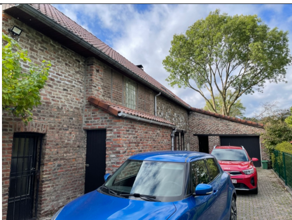
Photo 15 : façade arrière maison/ avant garage
