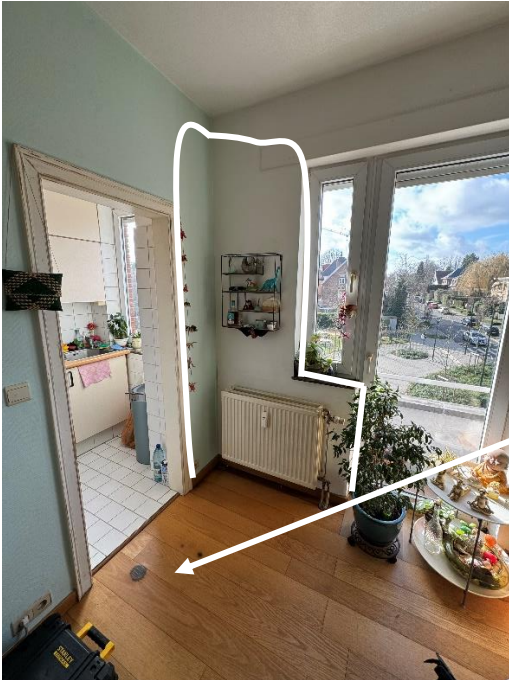
Taches noirâtres et humide dans le sol et sur le mur de la SAM
