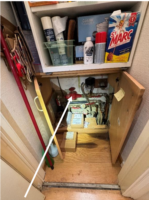
Compteur et vannes sur les circuits de chauffage – coulées depuis le purgeur de gauche
