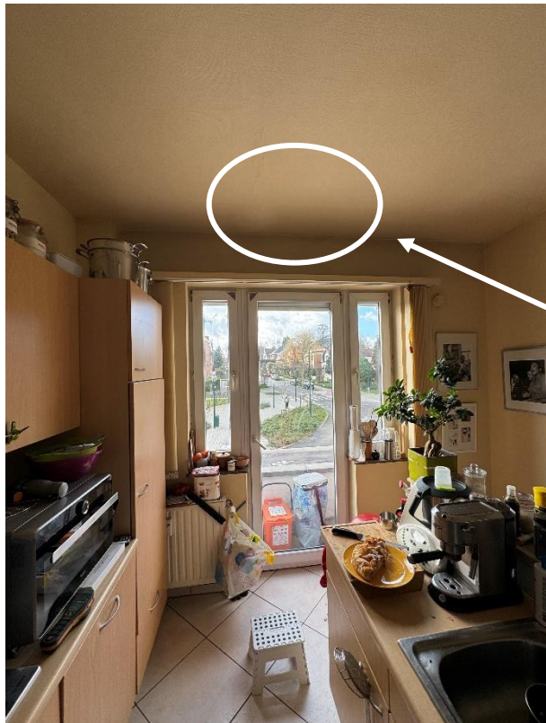
Humidité sur le plafond de la cuisine sous la terrasse du A2
