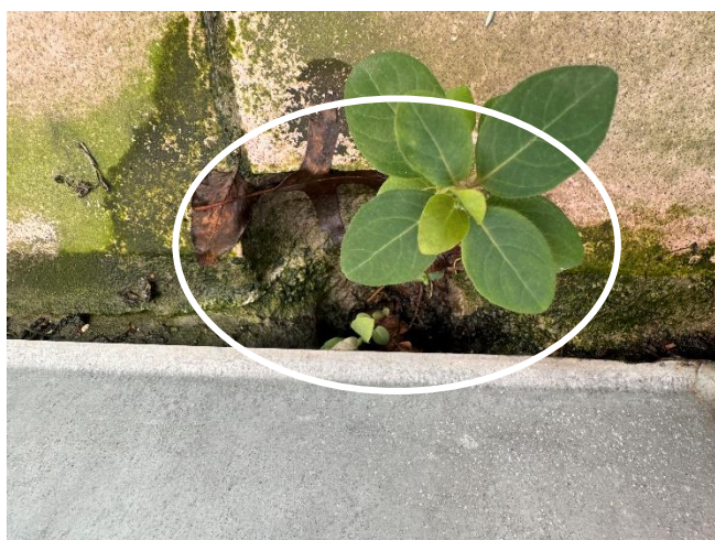
Plante dans l'évacuation et fissure dans le joint de ciment au bas du garde fous
