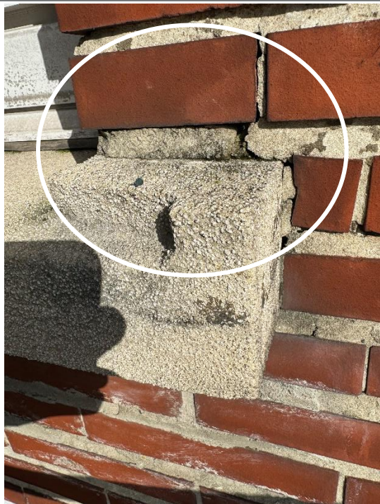
Joint de ciment fissuré autour du seuil de fenêtre - façade
