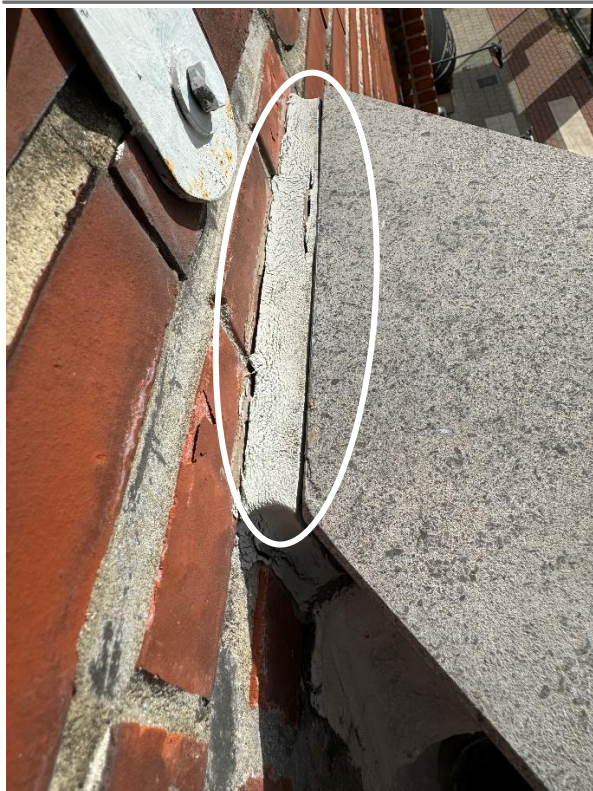
Joint de silicone déchiré – joint de ciment fissuré au bas du chassis de fenêtre
