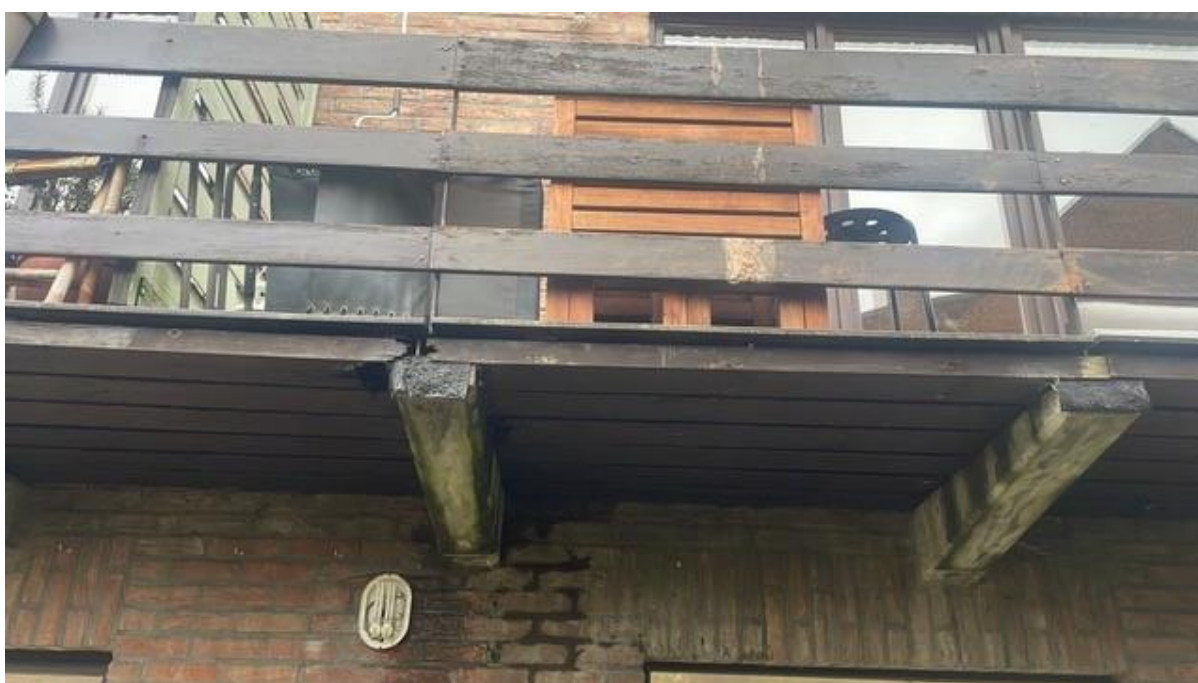
Photo 4. FACADE ARRIERE – Eléments Porteurs en Béton
