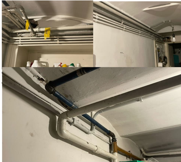
Figure 6 - Ancienne tuyauterie gaz à déposer
