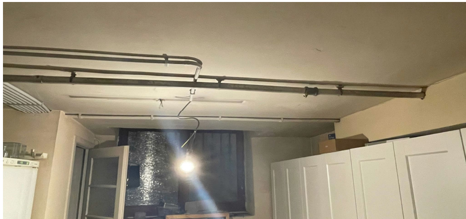
Figure 5 - collecteur eau usée sur lequel se raccorder
