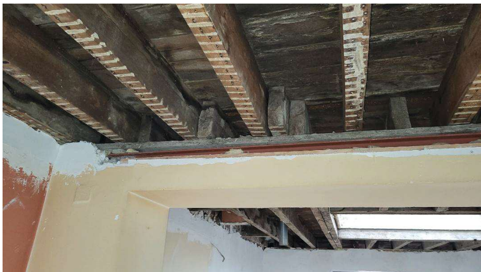
Photo 4 : Aperçu du gitage bois type (section, entraxe et sens de portée) constituant les planchers (ici 4 ème étage)
