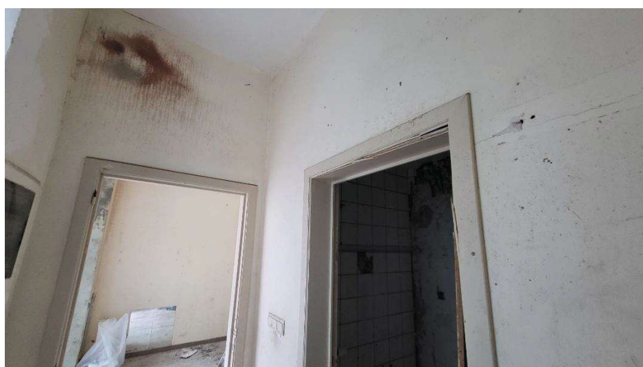
Photo 6 : Murs non porteurs (cloisons de 9 cm) à supprimer (annexe et salle de douche) ➡ Pas de disposition particulière à prendre ( confirmer )
