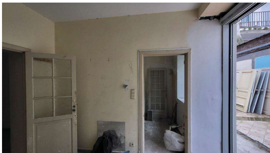
Photo 5 : Mur non porteur (cloison de 9 cm) à supprimer ➡ Pas de disposition particulière à prendre ( confirmer )
