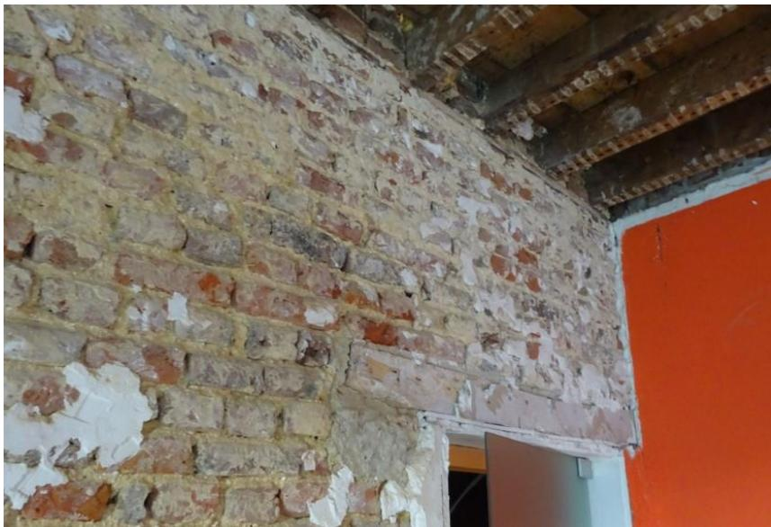
Linteau en bois à remplacer par linteau préfabriqué type Remacle 19x19 L=140
