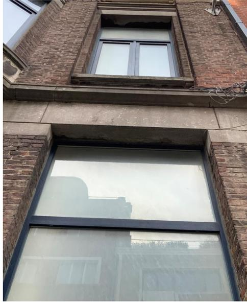
Figure 2 : Photographie du linteau extérieur en pierre bleue au droit de la porte d'entrée
