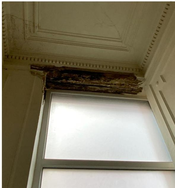
Figure 1 : Vue des linteaux intérieurs en bois au droit de la porte d'entrée
