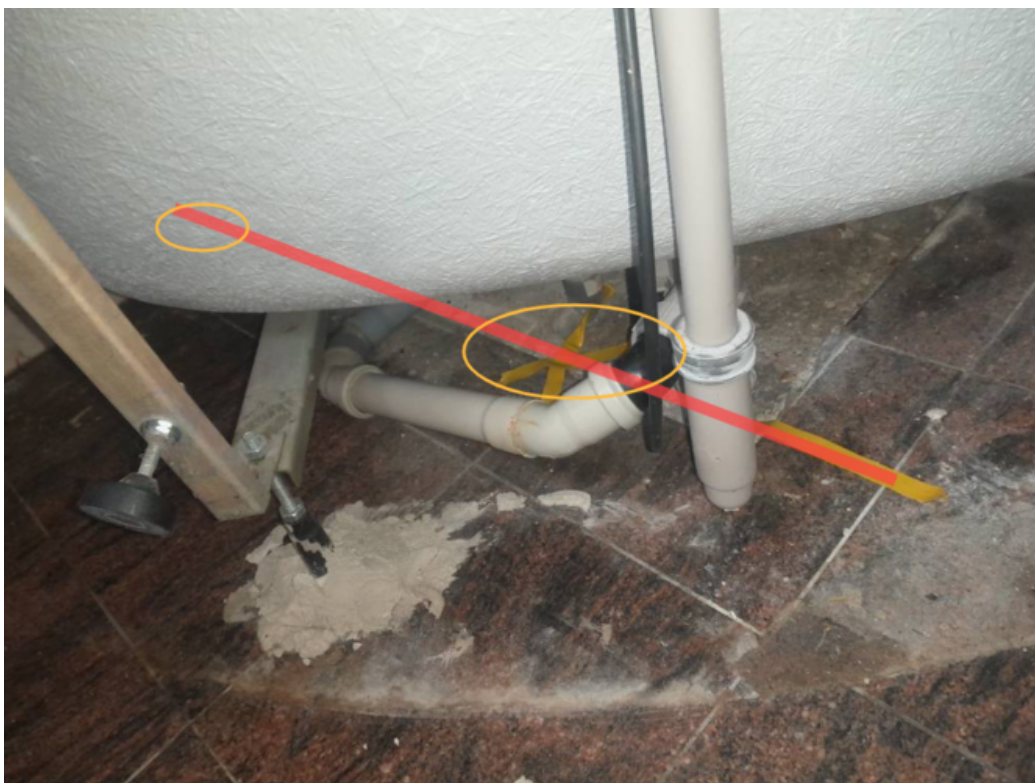
Photo 28 : lekindicatie op het warm watercircuit onder het bad
